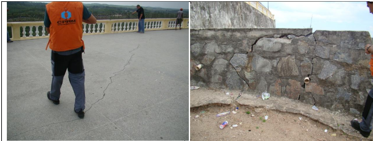
Trincas em piso e no muro indicando colapso do terreno subjacente
