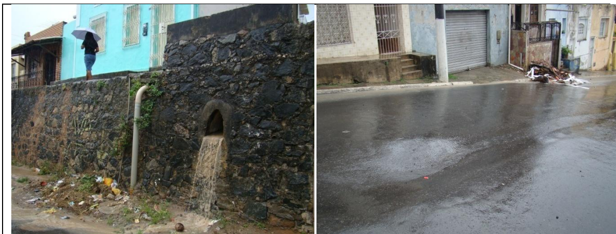
Trincas em piso e no muro indicando colapso do terreno subjacente
