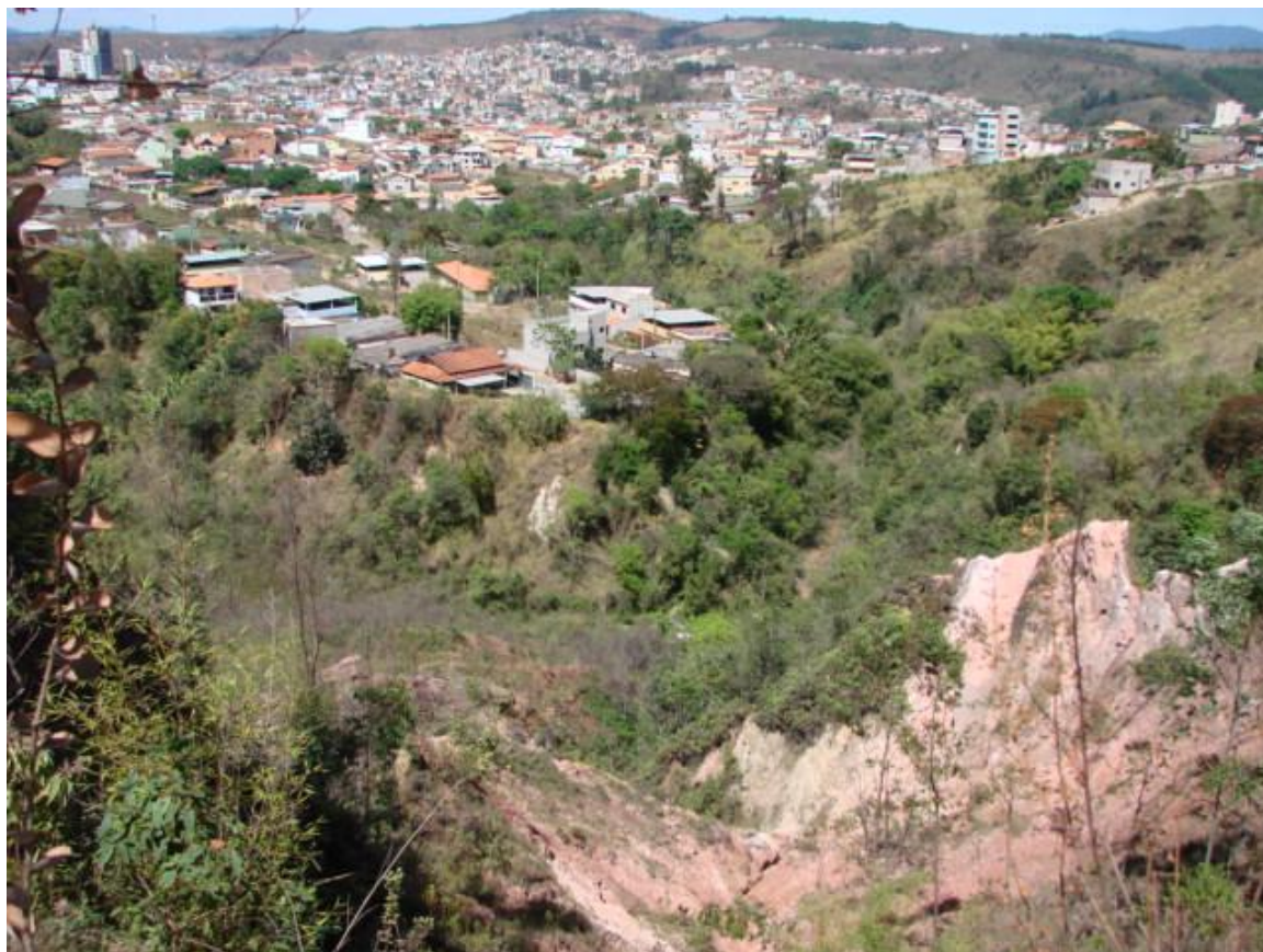
Figura 03: Exemplo de setor classificado como do tipo alto. Talude vertical (~90°), terreno com sulcos e ranhuras pronunciados, além de trincas no solo e árvores inclinadas. Foto do Setor 13 , nas proximidades do Bairro Resende.
