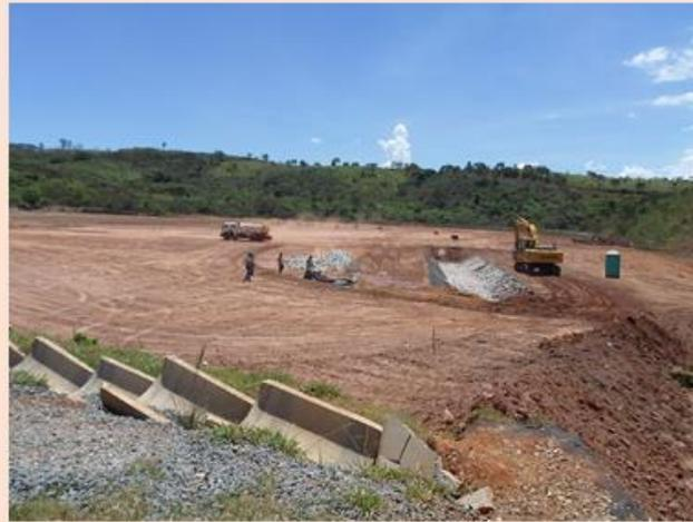
Obs.: Estrutura em processo de descomissionamento, toda a água foi dragada, a bacia aterrada, atualmente está em processo de hidrossemeadura para reintegração à natureza.
